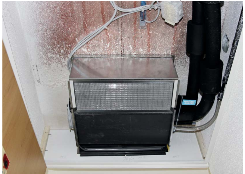
Heiz-/Kühl-Modul als Deckeneinbaugerät.
