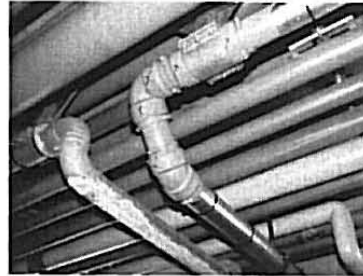
Starre Montage mit Fixpunkt bis Rohrdurchmesser 110 mm
