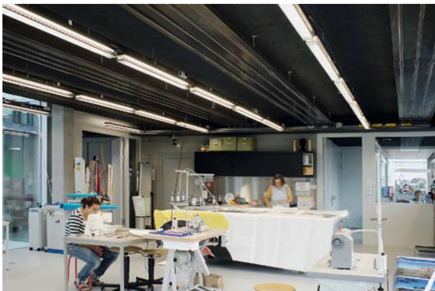
In der Zuwebe erweisen sich Zehnder Deckenstrahlplatten als eine bewährte Lösung, wenn es darum geht, intensiv genutzte Räume mit einem angenehmen Raumklima zu versorgen.
