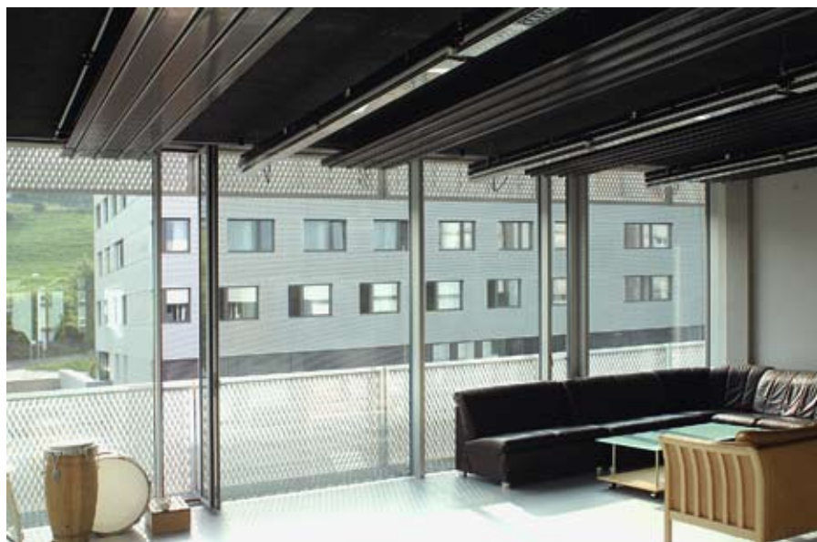
Auch die attraktiven Aufenthaltsbereiche der Zuwebe Werkstätten wurden mit Deckenstrahlplatten zur angenehmen Raumklimatisierung mit Heiz- und Kühlfunktion ausgestattet. Fotos Zehnder Heizkörper AG
