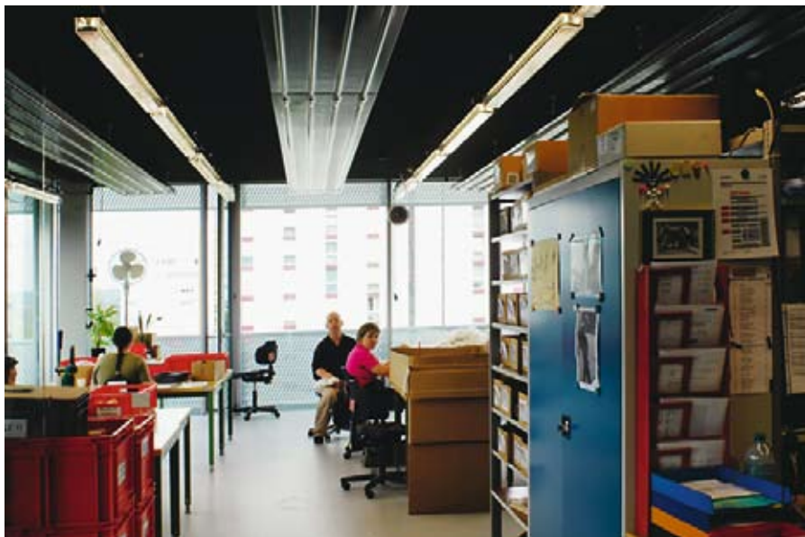
Aufgrund der grossen Glasflächen gab es wenige Optionen für den platzsparenden Einsatz konventioneller Heizkörper. Die Lösung mit Deckenstrahlplatten spart wertvolle Nutz- und Arbeitsfläche.
